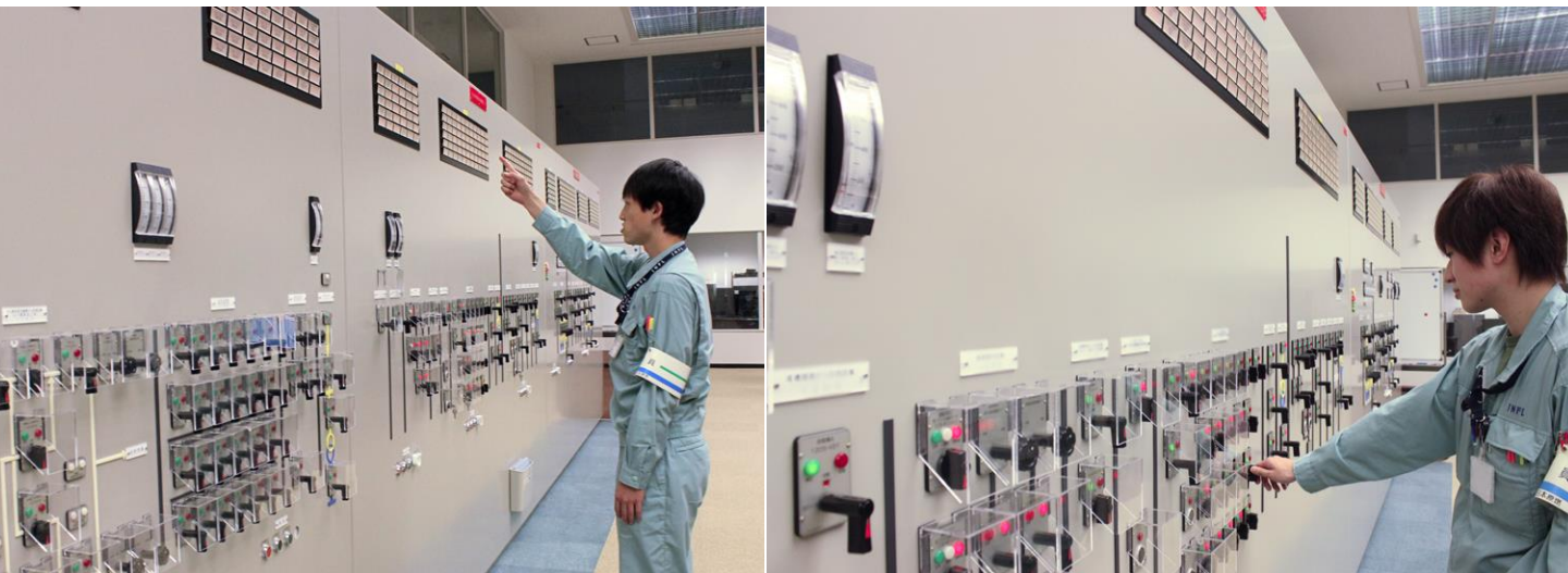
指差呼称「警報確認、ヨシ！」→ 制御盤を操作
