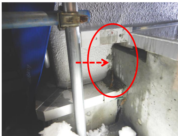
浸入箇所 (拡大)
