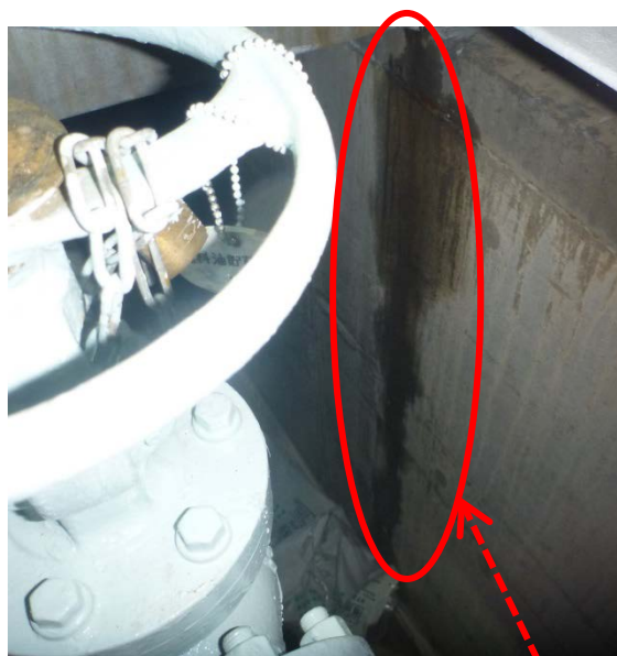
10月21日配管ピットB
