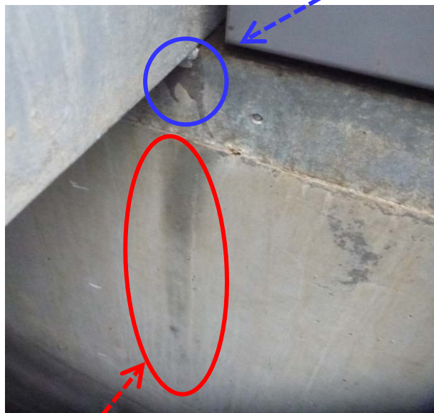
10月22日配管ピットA
