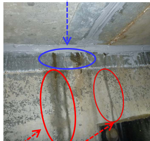
10月22日配管ピットB
