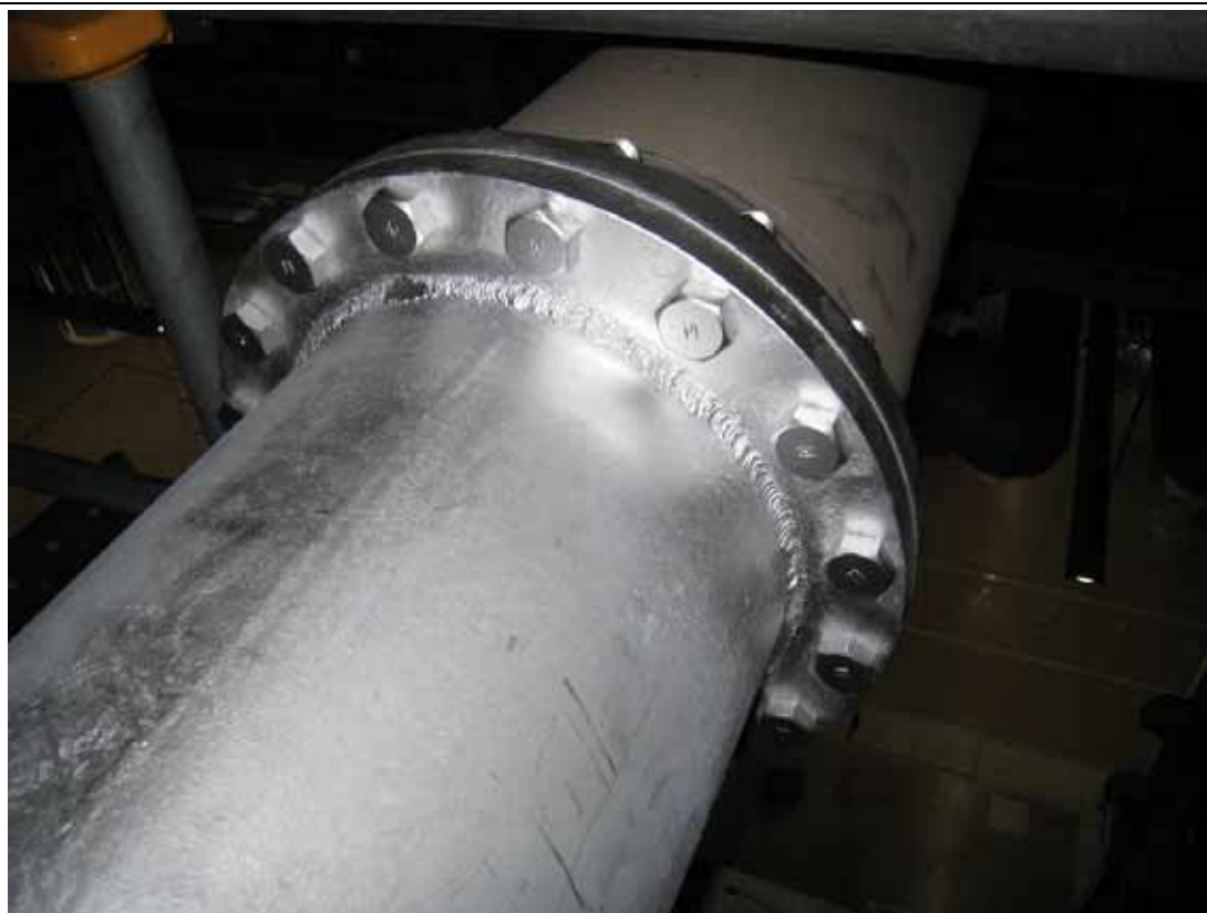
■12: プロセスユーティリティ配管 フランジ溶接部錆有り (例) 補修後
