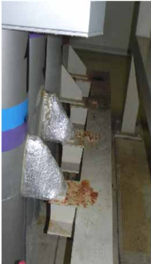
■15：プロセスユーティリティ配管架台の錆有り（例）補修後
