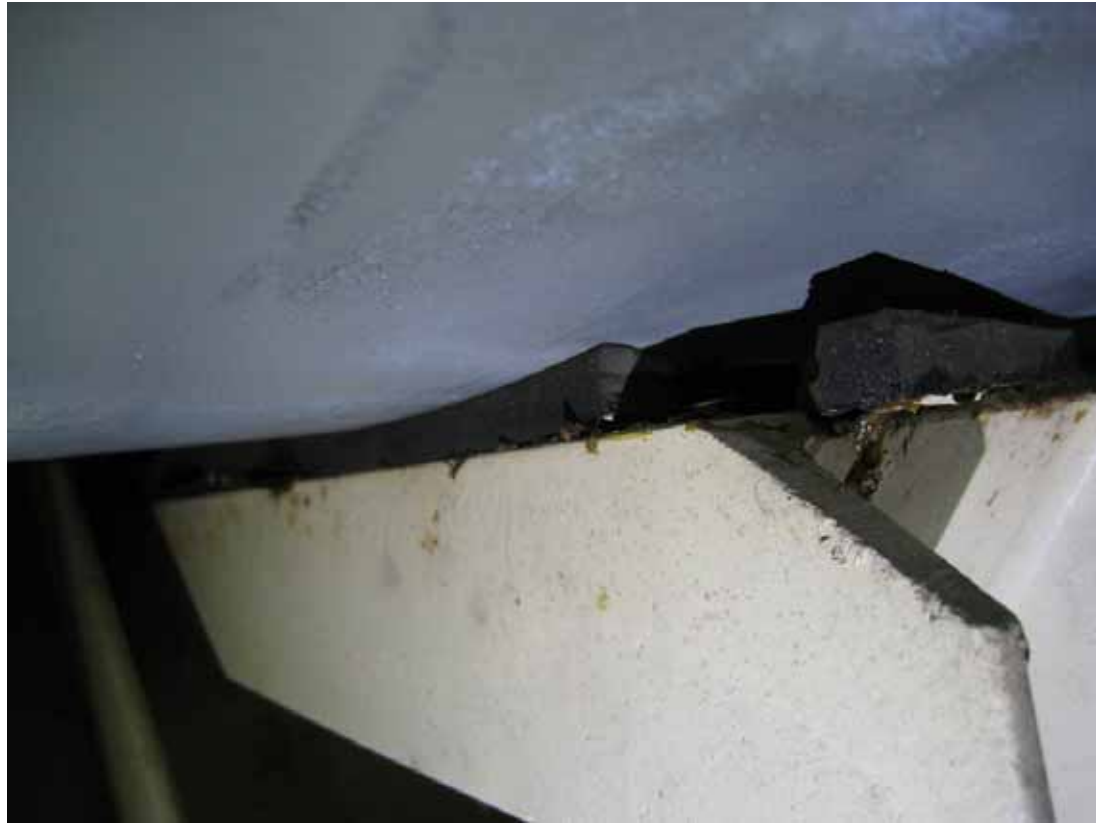
▲24：シリンダ置台ラバーの割れ（例） △
