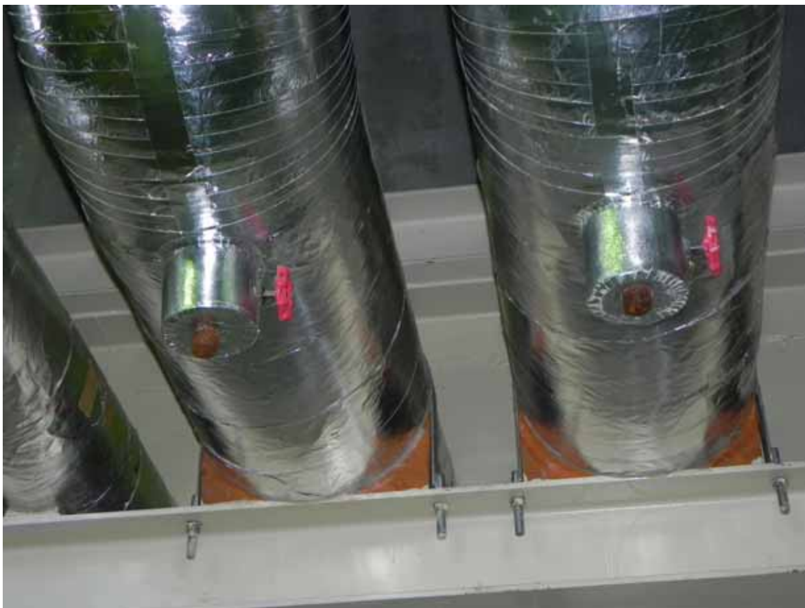
■14: ユーティリティ保温配管 プラグ錆有り △
