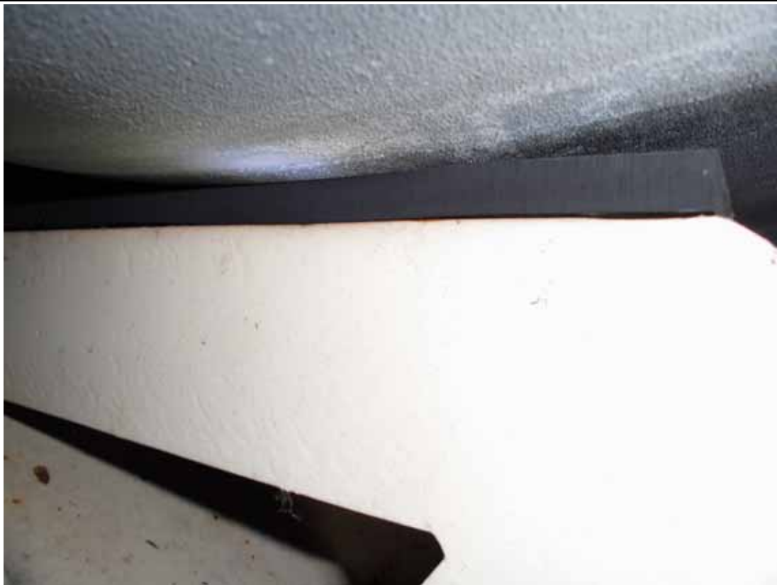
▲24：シリンダ置台ラバーの割れ（例） 補修後
