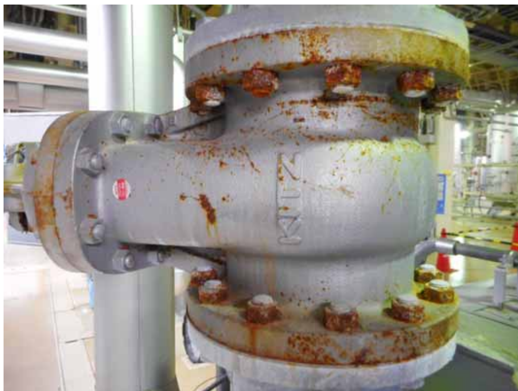
■13: ユーティリティ配管 バルブの錆有り (例) △
