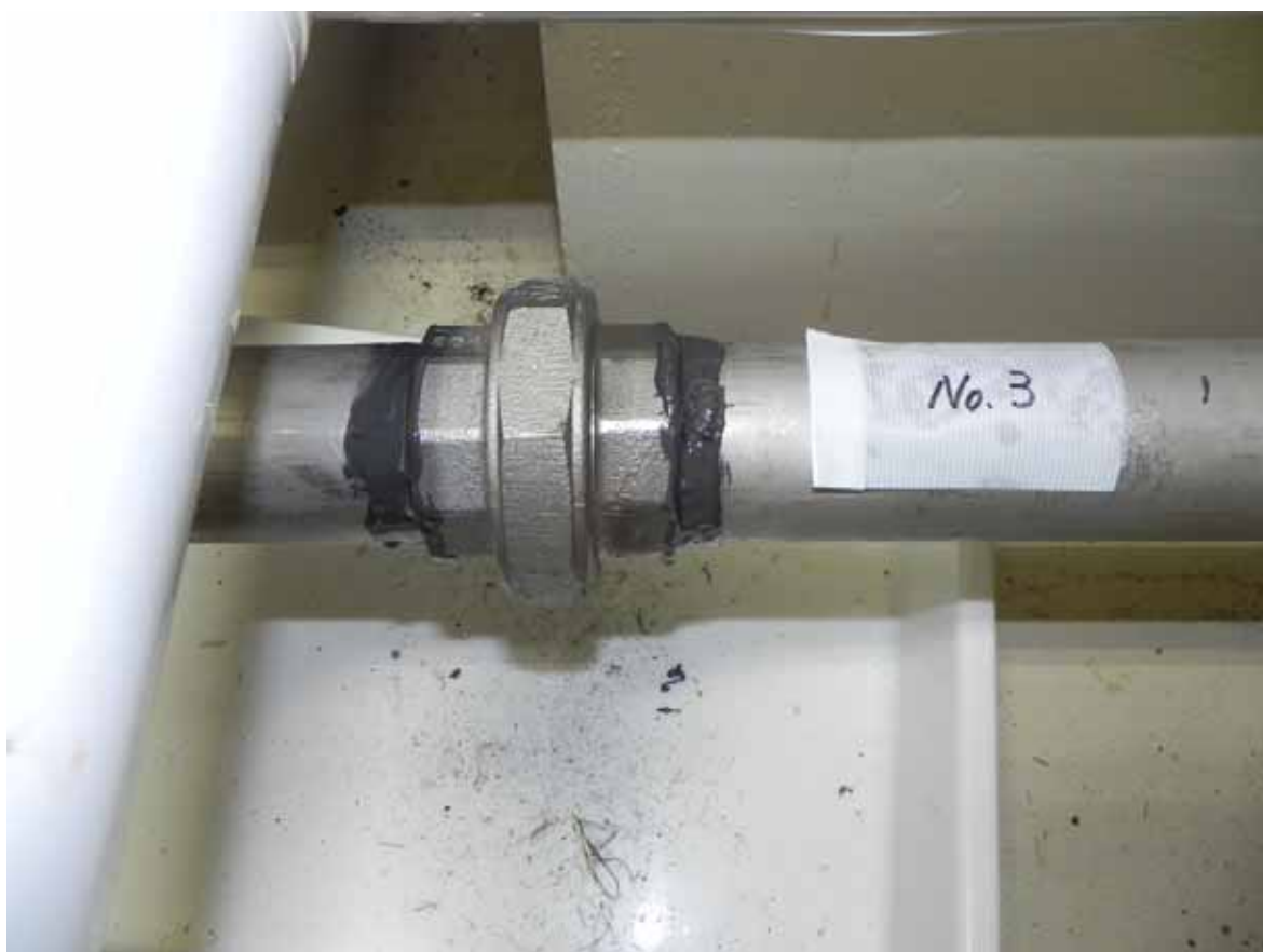
▼19：分析室廃水ピット配管 漏えい痕有り（例） 補修後
