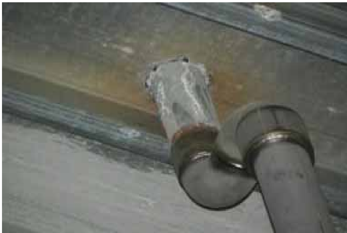
▼22 : 排気口ドレン配管の液だれ痕有り△
