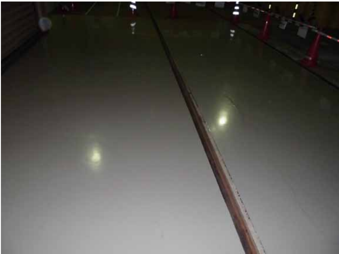
◆ 25 : 床塗装の剥がれ (現在補修中)
