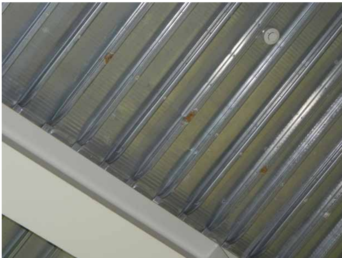
▼22 : 排気口ドレン配管の液だれ痕有り△
