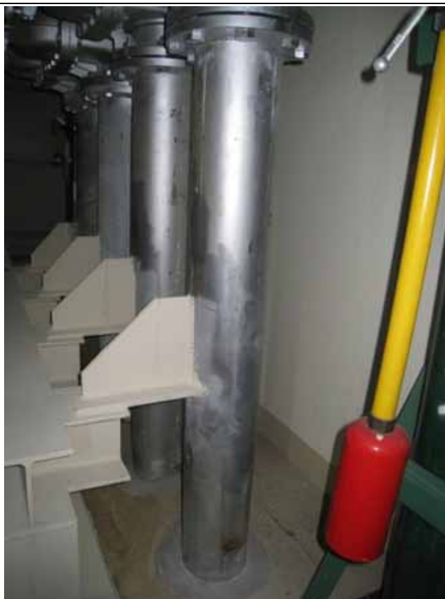
■15：プロセスユーティリティ配管架台の錆有り（例）補修後
