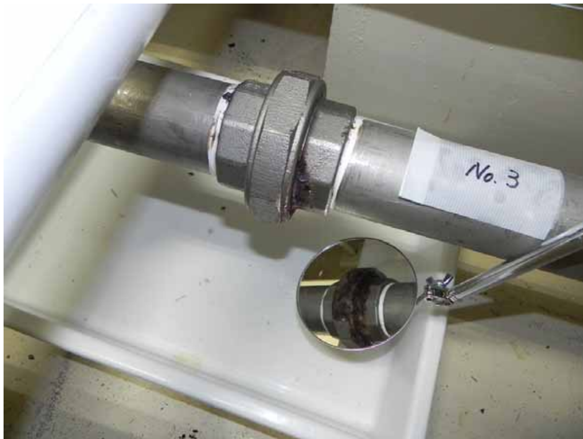
▼19：分析室廃水ピット配管 漏えい痕有り（例） △
