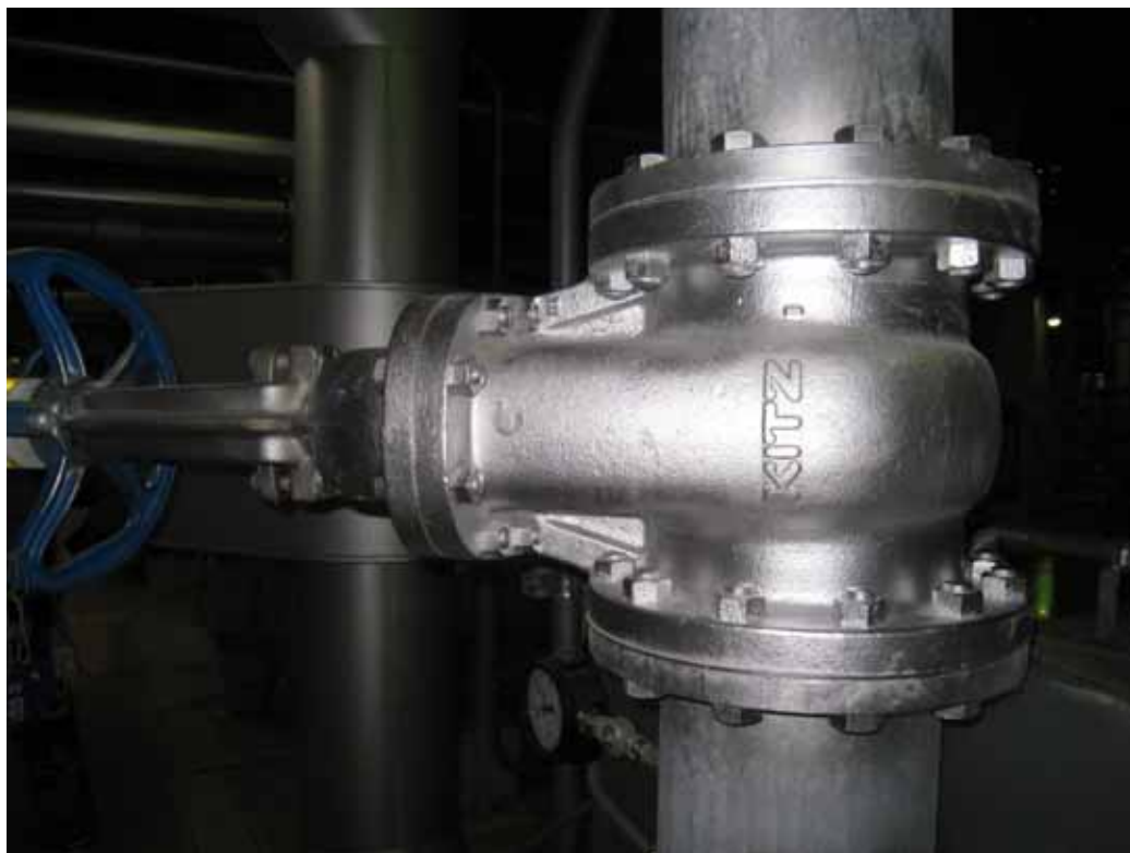
■13: ユーティリティ配管 バルブの錆有り (例) 補修後
