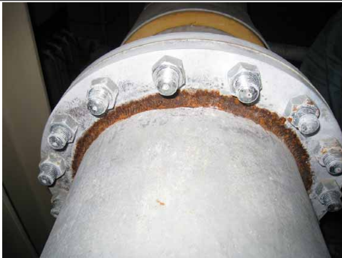
■12: プロセスユーティリティ配管 フランジ溶接部錆有り (例) △
