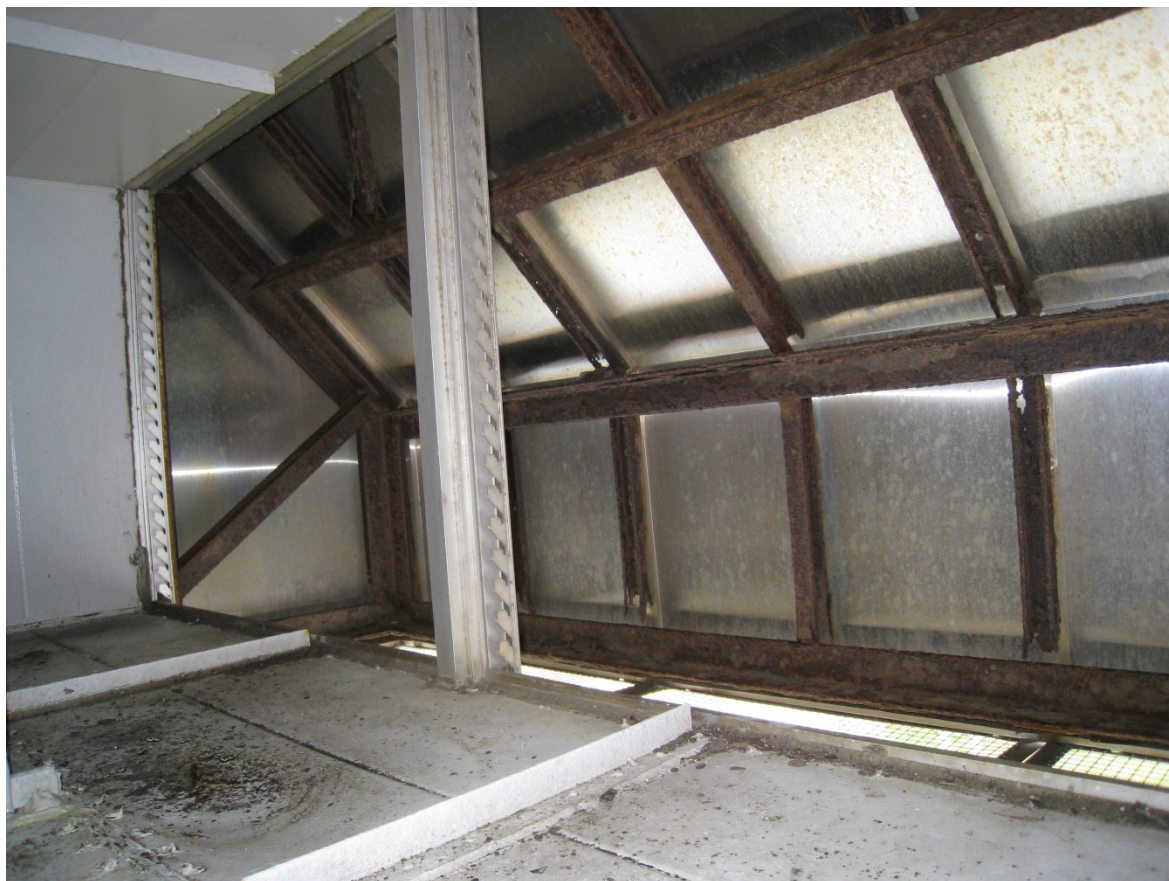
①-2 : ダクト内部 型鋼の錆他 △
