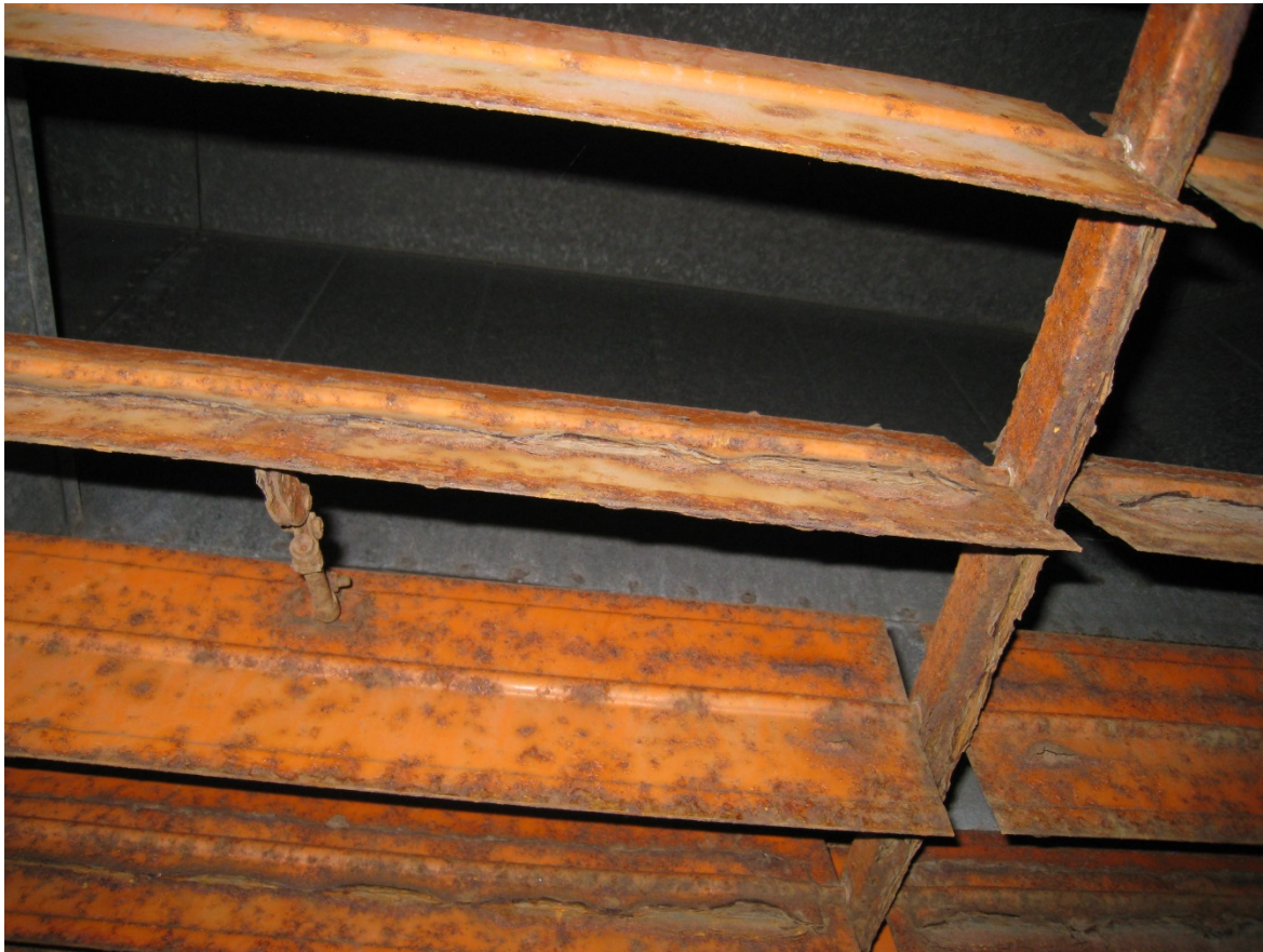
①-2 : ダクト内部 型鋼の錆他 △
