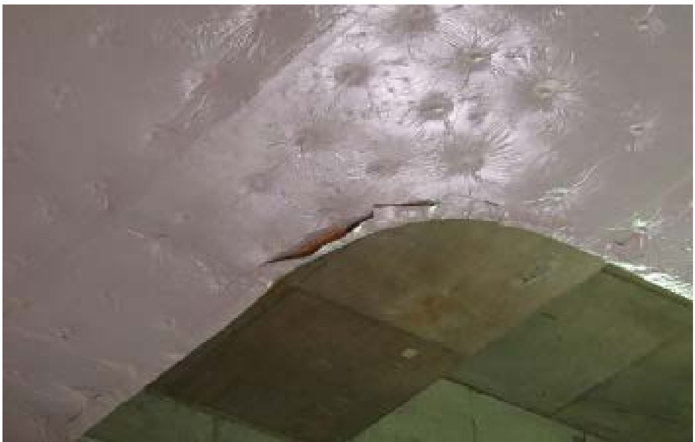
⑨-2：1号均質室(給気ダクト保温材の一部剥れ) △
