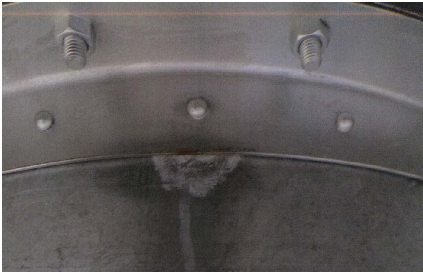
⑧-5 : 排気ダクトフランジ継ぎ目に錆有り △
