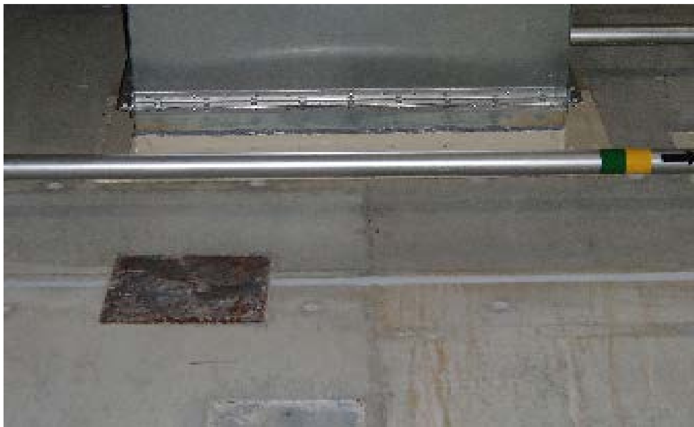
⑫-2：B、C付着ウラン回収廃棄物室(排気ダクトの変色(錆色)) △
