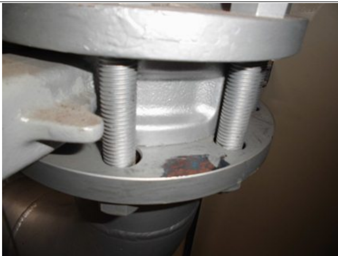
⑫-4 : 2B カスケード CS 系機械排気系統フランジ 塗装剥げ有り △
