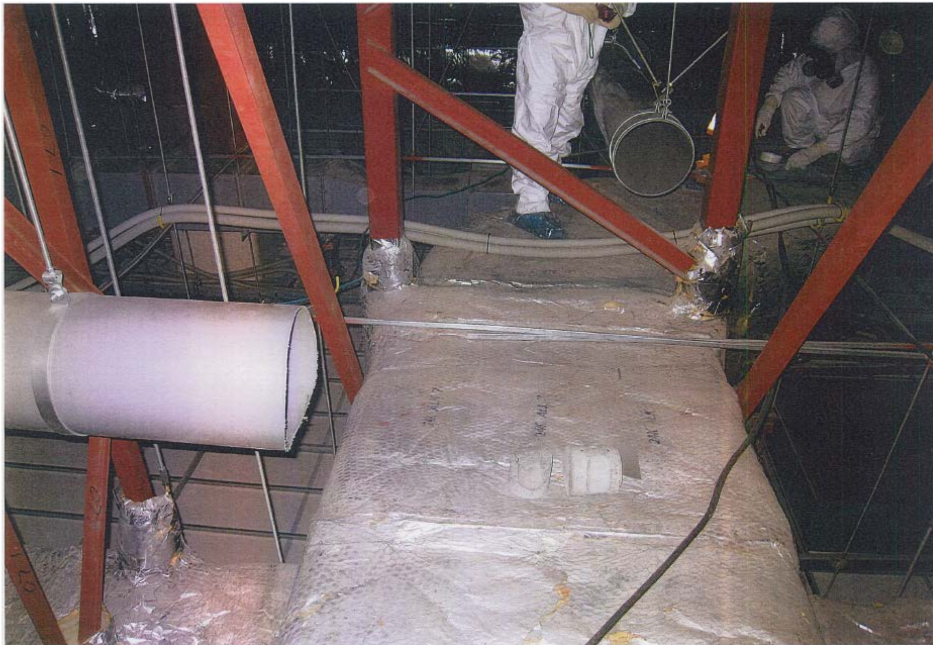
ウラン濃縮工場 排気ダクトの点検状況（写真）
