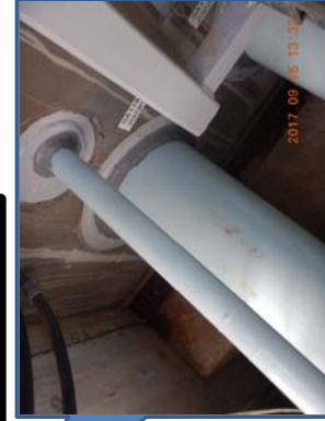
ケーブルピット貫通部
