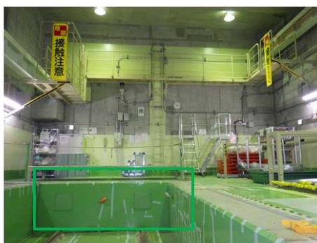
図－1 使用済燃料受入れ・貯蔵建屋における水の浸入を防ぐ壁面の適切な位置への見直し外略図
