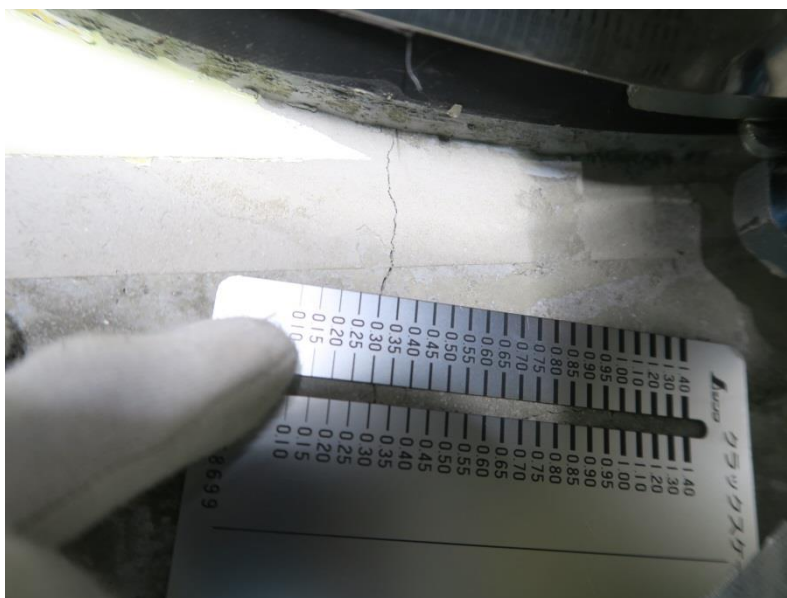
図－2 貫通部の亀裂・損傷の例
