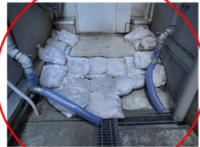
土のうの設置状況
