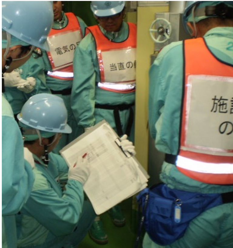
精製建屋の現場確認の状況（10/11 撮影）
