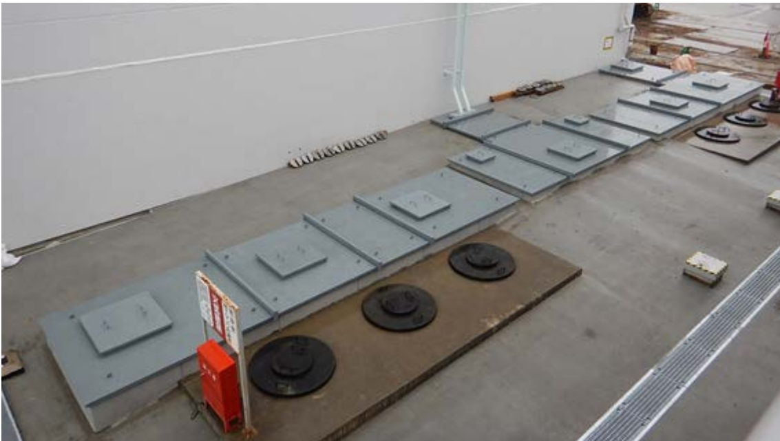
配管ピットB系（10/29 撮影）
