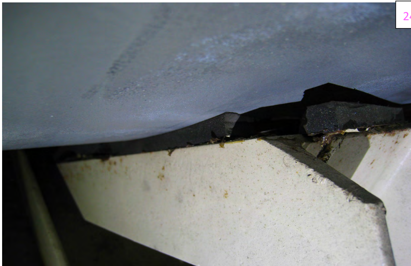
▲24：シリンダ置台ラバーの割れ（例） △
