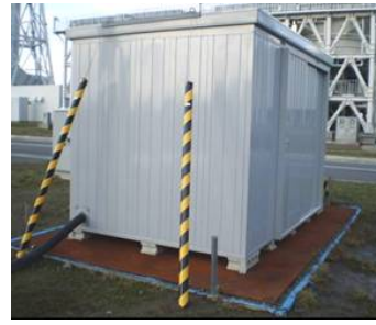
図2 電源ケーブル小屋の補強
