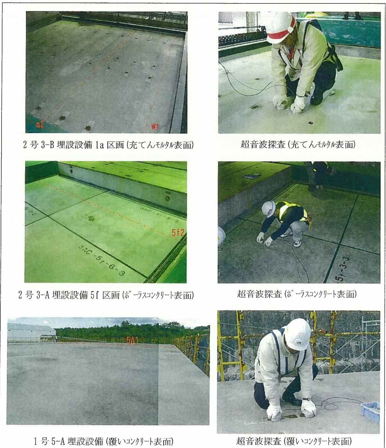
写真-3 超音波探査実施写真
