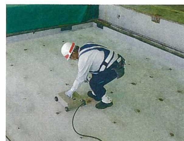
1号5-E i区画探査状況
