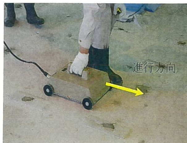
電磁波レーダ (アンテナ)
