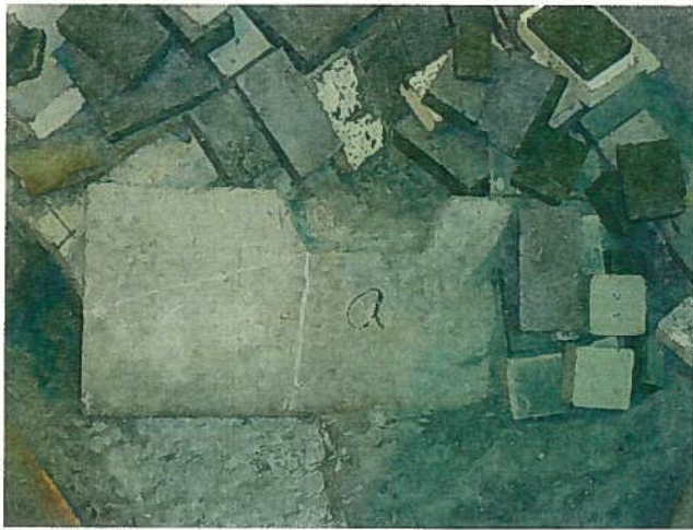
上部スペーサーブロック a 取出し前
