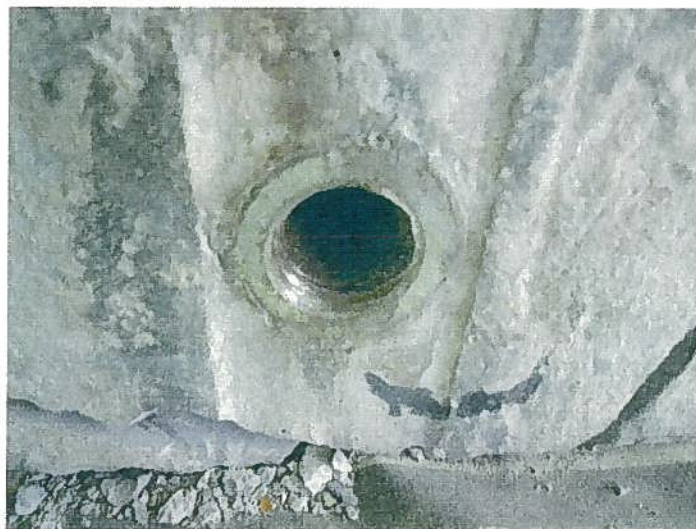
図-3-5 ねじ込み部確認状況
