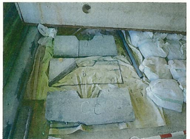
上部スペーサーブロック 取出し後
