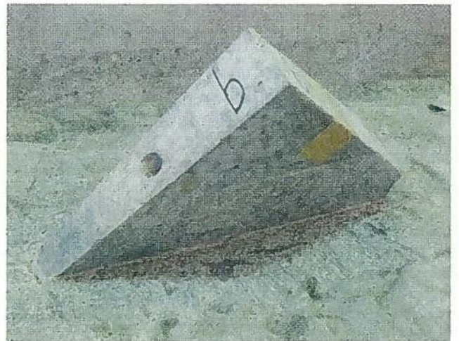
上部スペーサーブロック b 取出し前
