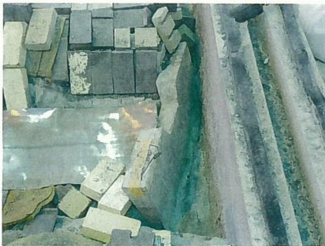
上部スペーサーブロック c 取出し前
