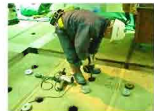
プラグ挿入・締付け
