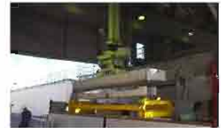
コンクリート仮蓋吊り込み
