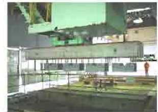
コンクリート仮蓋仮置き
