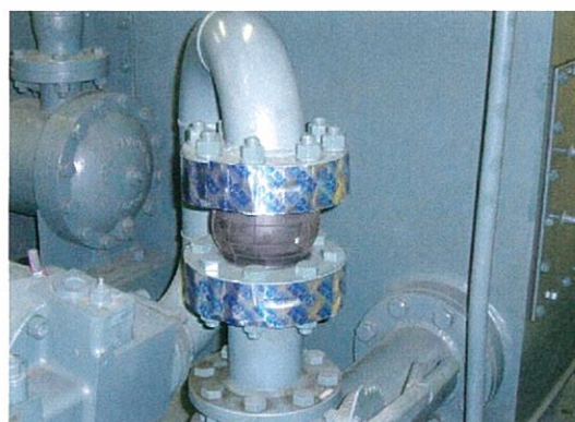
飛散防止テープ貼り付け後
