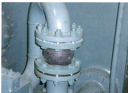
飛散防止テープ貼り付け前
