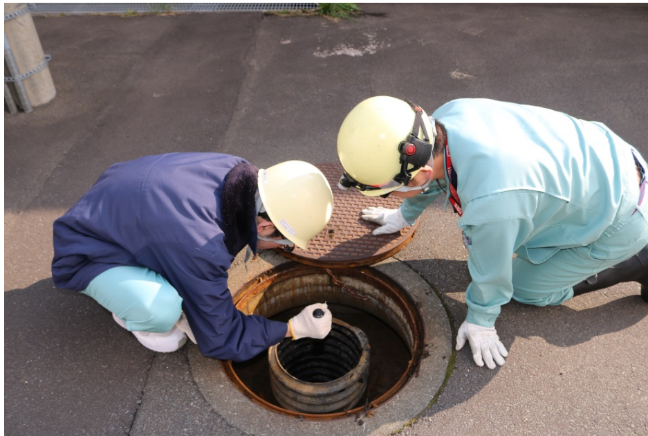
マンホールの確認
