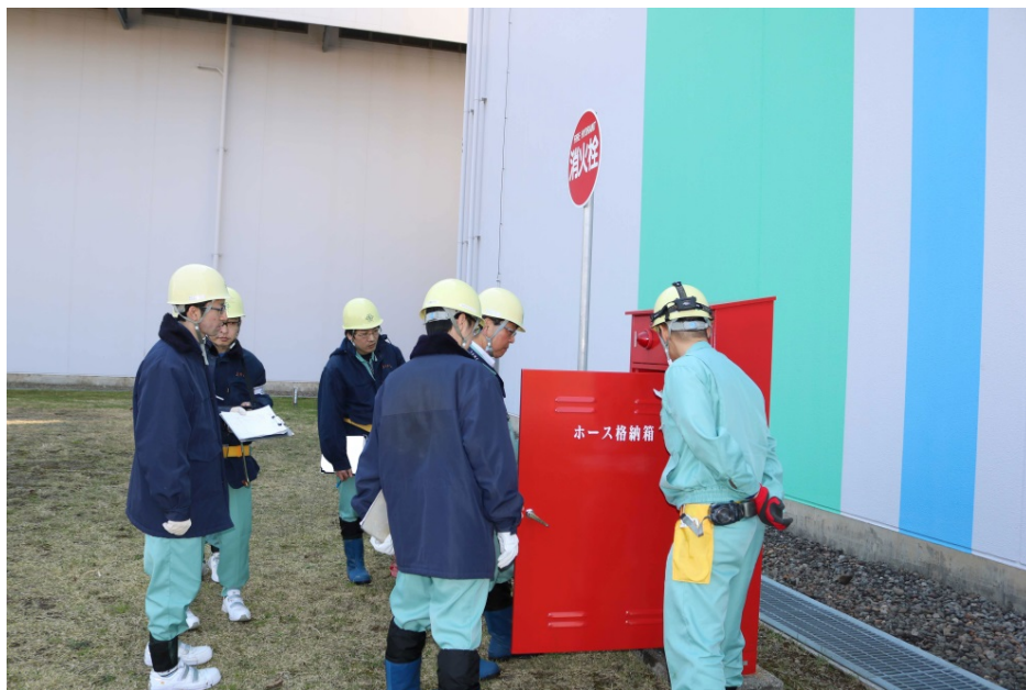
消火栓の確認
